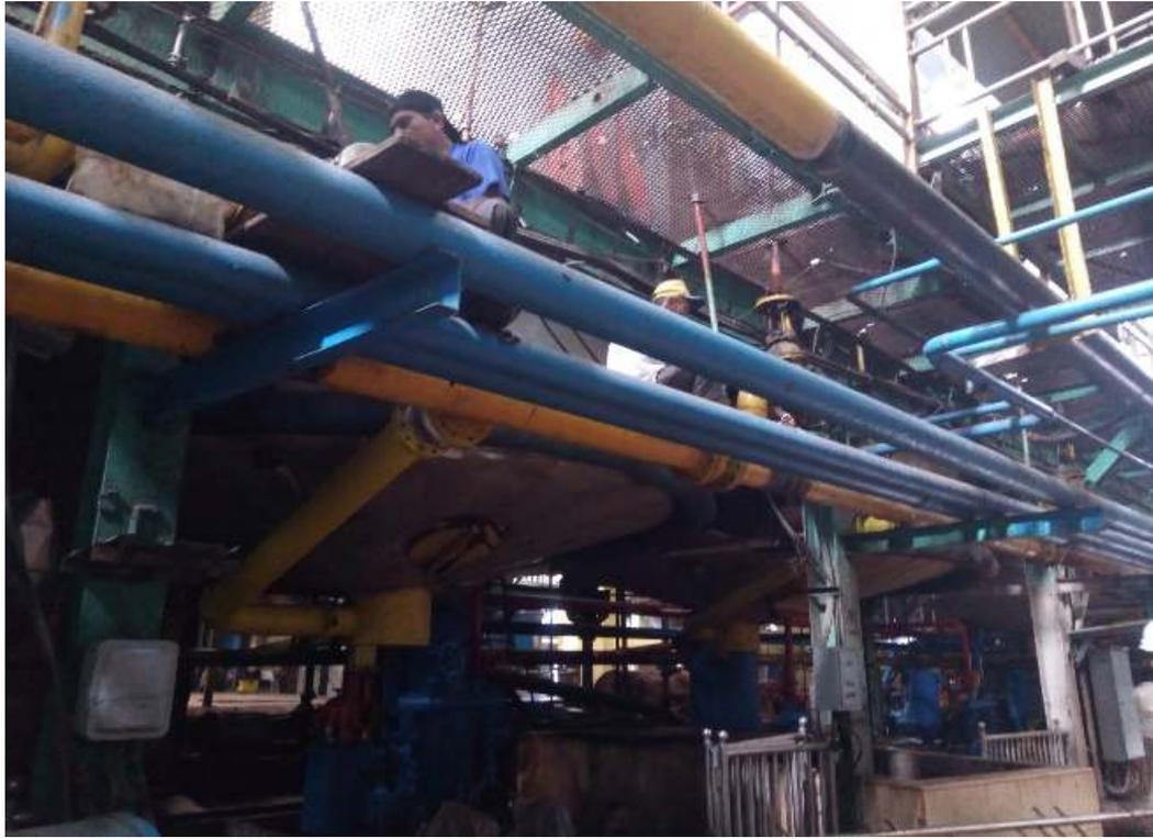
Foto diatas merupakan gambaran pekerja yang sedang melakukan perbaikan alat pada stasiun masakan. Tampak jelas bahwa pekerja tersebut melakukan perbaikan diatas mesin tanpa menggunakan APD (Alat Pelindung Diri) berupa sabuk pengaman sehingga memungkinkan pekerja terjatuh dan mengalami kecelakaan kerja. Motivasi yang kurang dalam penggunaan APD saat bekerja menyebabkan pekerja dekat pada bahaya.
