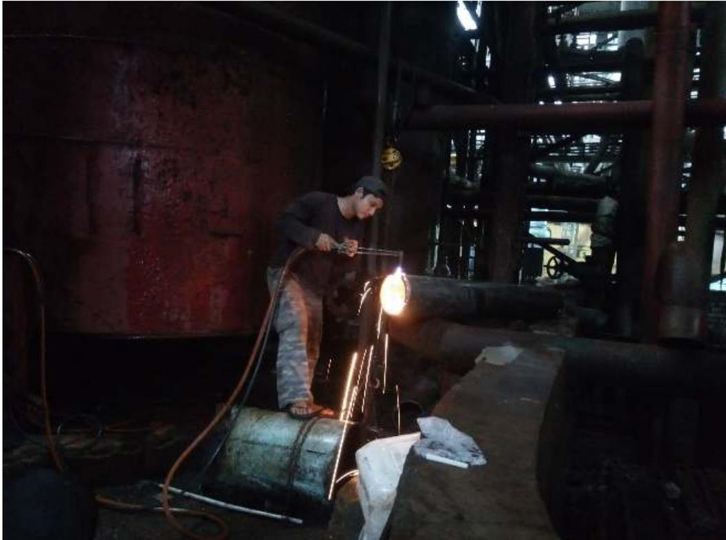
Foto diatas merupakan foto pengelasan, terlihat bahwa pekerja pengelasan tidak memakai APD berupa sarung tangan dan penutup wajah. Hal tersebut merupakan salah satu contoh tindakan tidak aman yang dapat menyebabkan kecelakaan kerja seperti tangan pekerja melepuh terkena percikan api pengelasan dan juga area wajah juga dapat terkena percikan api.
