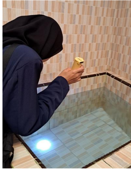
Kondisi bak mandi tidak berjentik
