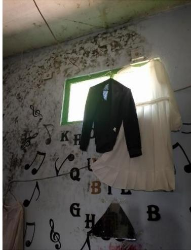
Gambar 13. Ventilasi tertutup baju
