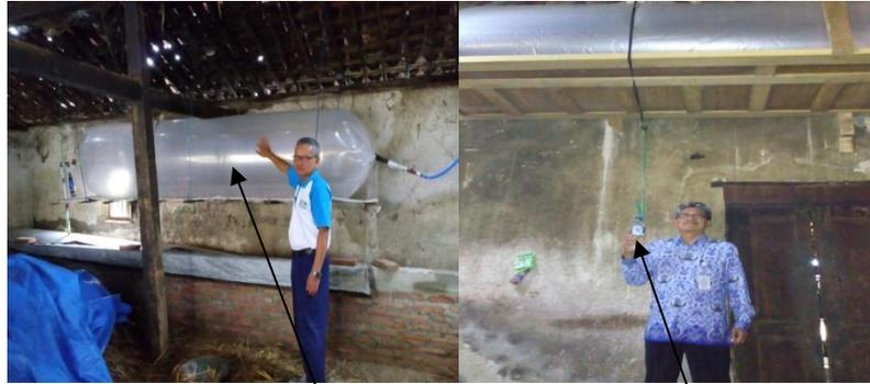
*Gambar : Tanki biogas dan Botol pemberat*
