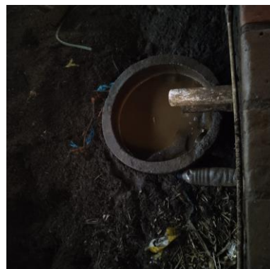
Gambar. 5 Kondisi saluran atau penampungan air limbah
