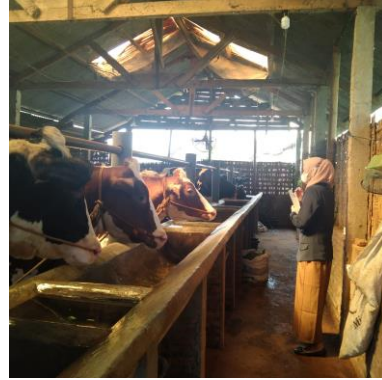
Gambar. 2 Kondisi Atap Rusak
