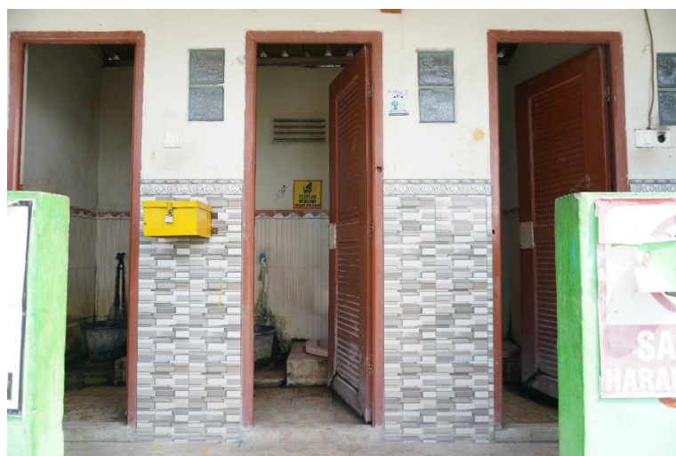
Kondisi WC Umum Bantuan dari Pemerintah Kabupaten Tuban
