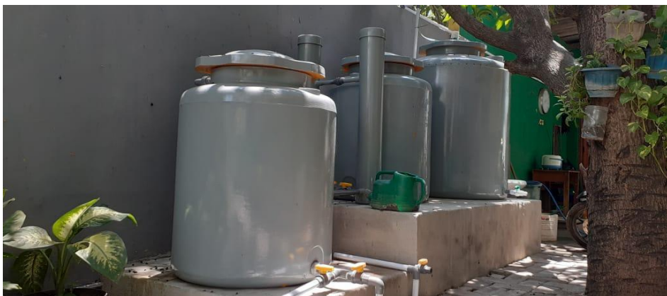
Model Unit Pengolah Air Limbah Dengan Bioball atau Biofilter Secara Aerob
