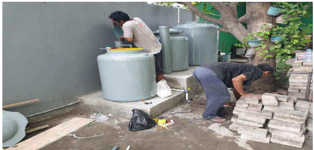
Pengisian Kerikil dan Pasir Pada Tnki Saringan Pasir
