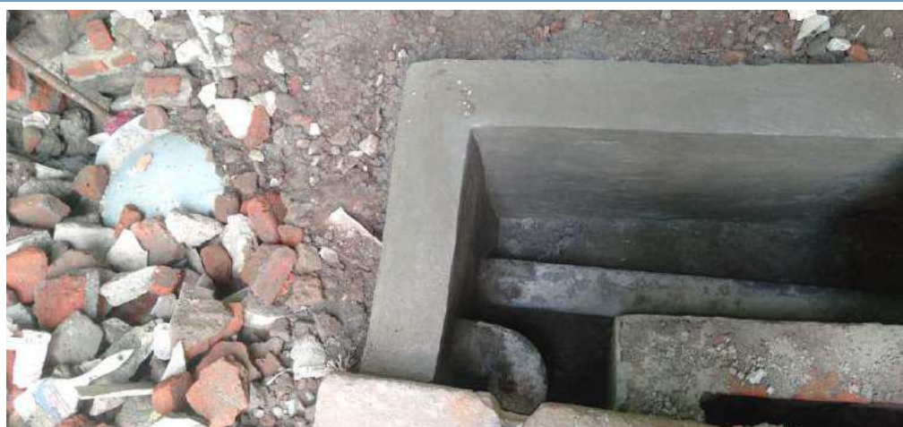
Grease Trap (Perangkap Minyak) Sebelum Air Limbah Masuk Ke Tandon Pengumpul
