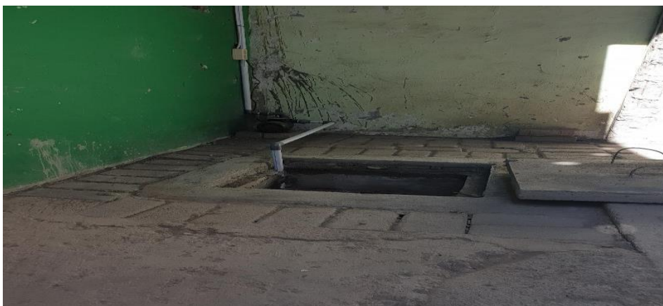
Koneksi Semua Sumber Air Limbah Tanki Pengumpul Dipompa ke Unit Pengolah Air Limbah
