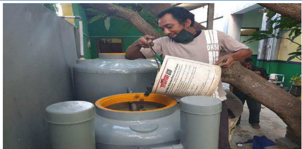
Pengisian Bioball Pada Tanki Pengurai ( Bioball Reactor )
