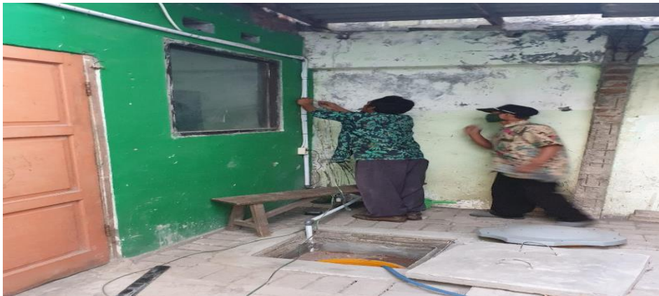
Pemasangan Kinerja Pompa Otomatis Dari Taki Pengumpul ke Unit Pengolah Air Limbah
