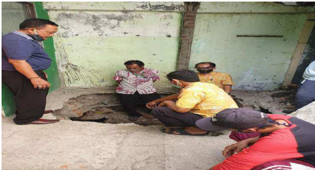
Galian Bak Pengumpul ( Equal Tank ) Air Limbah Dari Semua Sumber
