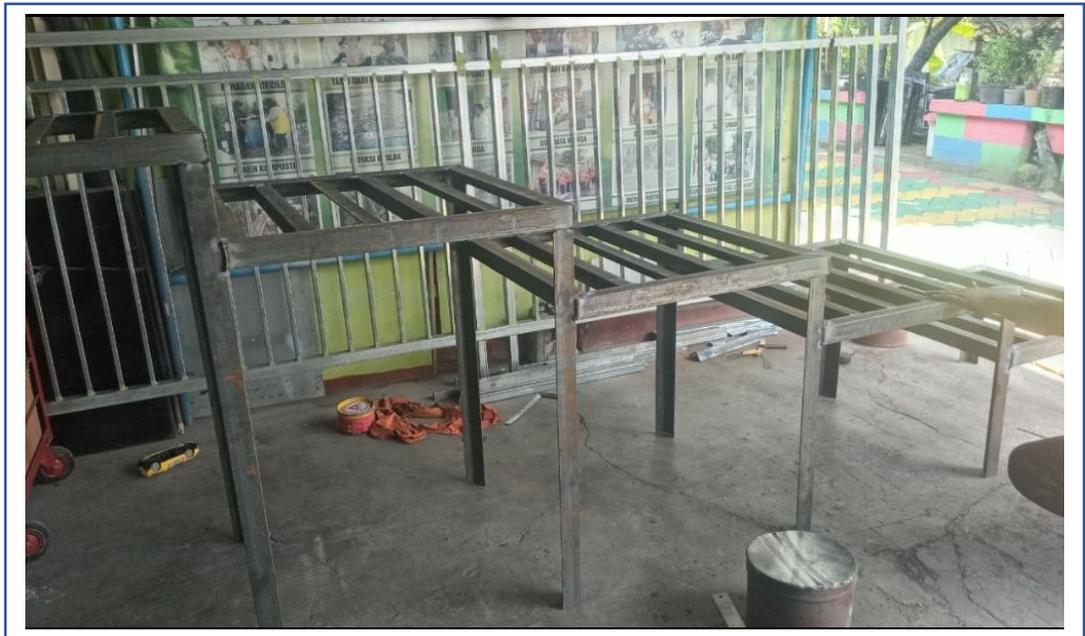
Foto : Pembuatan Tutup Bis Beton untuk tandon dalam tanah sebagai penampungan air limbah dari masyarakat dan Toilet umum serta Kerangka baja tempat landasan Profil (Jum'at, 19 Juni 2021)
