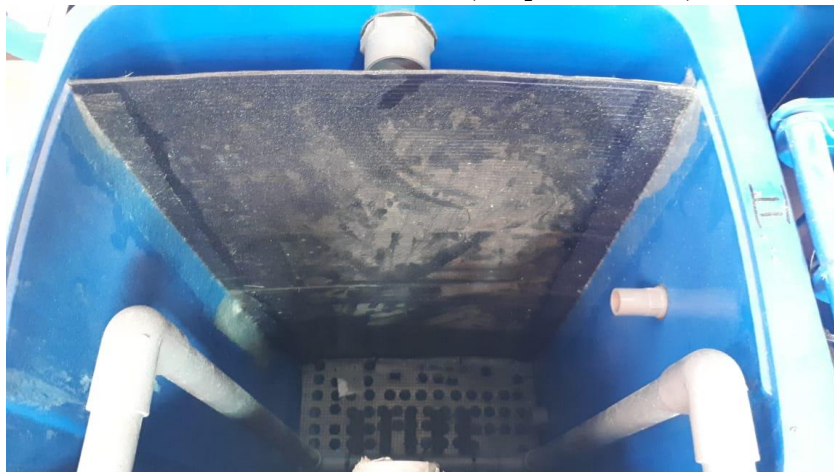
Gambar 4.5. Bak Aerasi tampak dalam (dilengkapi lubang diffuser dan perforator)
