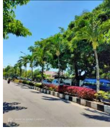
Jalur Hijau Jalan Tipe Median Jalan
