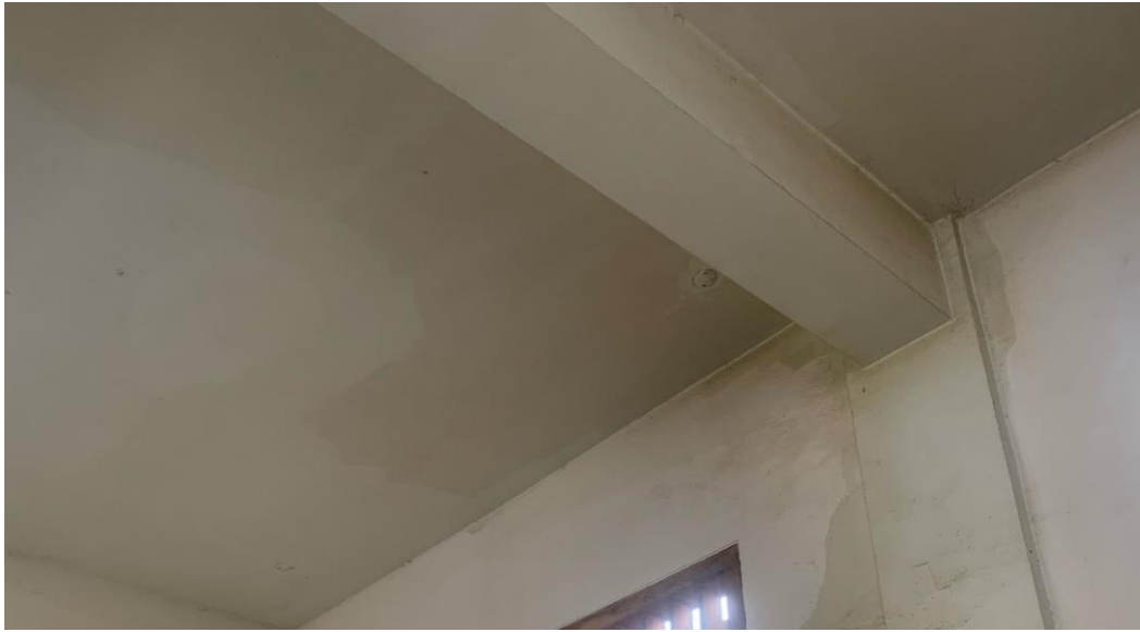
Gambar 3 Langit-langit ruang penyimpanan
