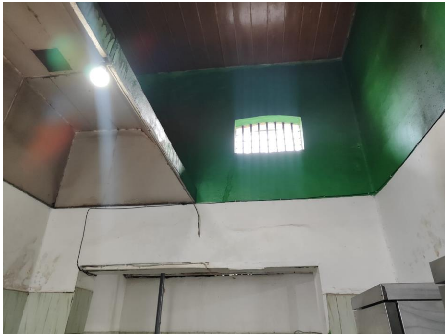
Gambar 14 Dinding ruangan pengolahan pangan
