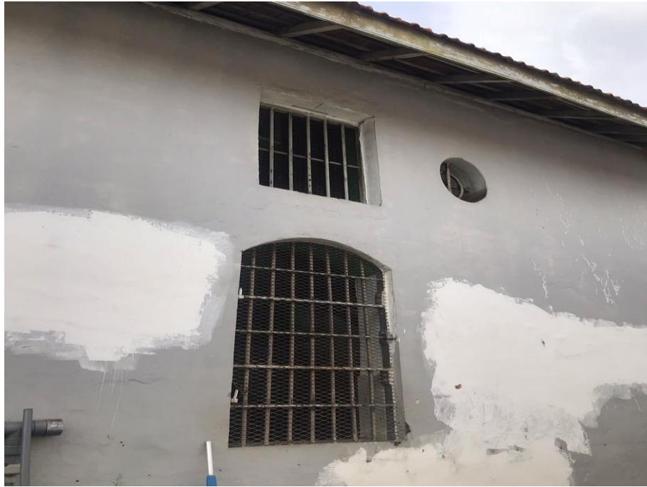
Gambar 3 Bangunan area luar dapur
