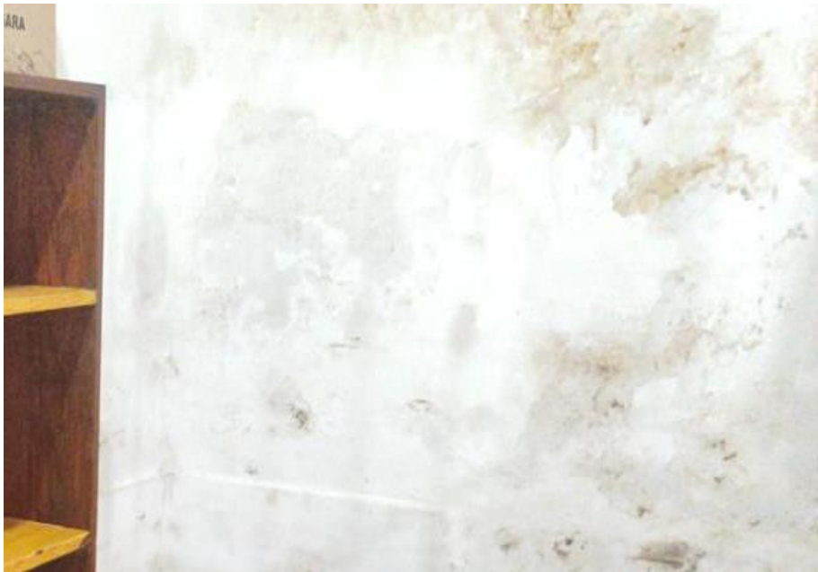
Gambar 8 Dinding area penyimpanan umum
