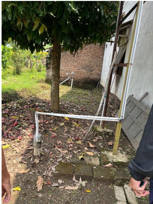
Pengecekan jarak sarana air bersih dan septic tank rumah penderita
