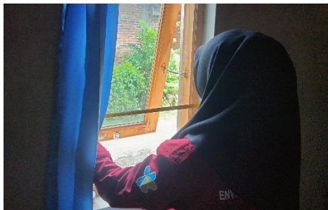
Pengukuran ventilasi ruangan
