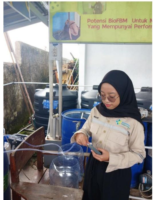
Gambar 8. Pemasangan Bubble Aerator pada Selang
