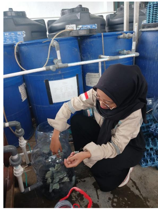
Gambar 10. Memasukkan Media Filtrasi Kedalam Bak Filtasi
