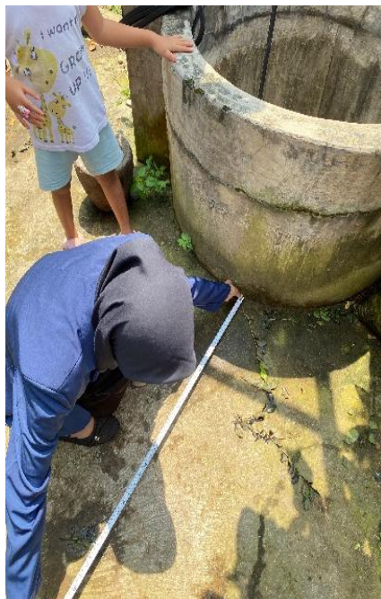
Lantai sumur berupa semen yang mengitari mempunyai jarak tidak kurang dari 1 meter
