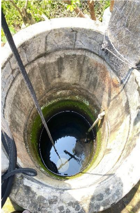
Dinding sumur memiliki kedalaman 3 meter dari lantai/tanah
