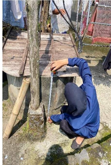
Bibir sumur berada 80 cm dari atas permukaan tanah
