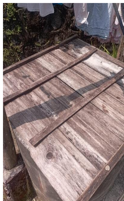
Penutup sumur terbuat dari bahan yang kuat dan kedap air
