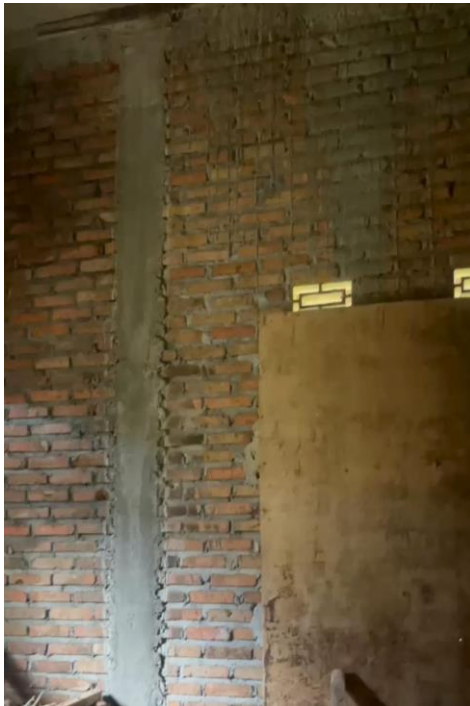
Dinding batu bata
