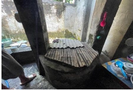
Gambar 9. Observasi pada Penutup Sumur Gali
