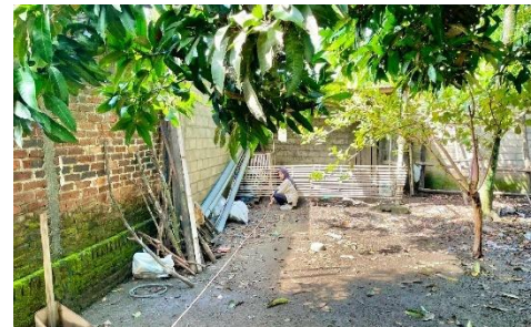
Gambar 4. Pengukuran Teknis Bangunan Sumur Gali pada Sumber Pencemar
