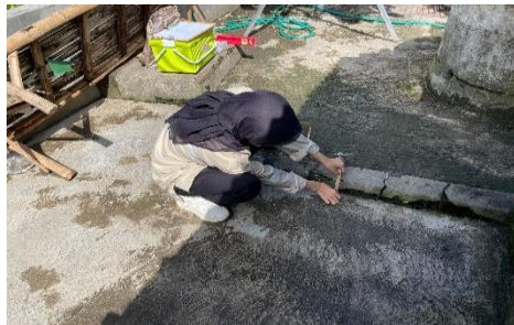
Gambar 3. Pengukuran Teknis Bangunan Sumur Gali pada Lantai Sumur
