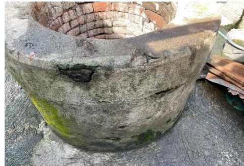
Gambar 2. Kondisi Teknis Bangunan Sumur Gali pada Dinding Sumur Gali
