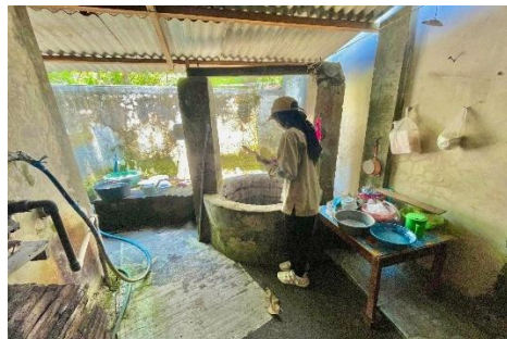
Gambar 5. Kondisi Teknis Bangunan Sumur Gali yang tidak Mempunyai Lantai Sumur
