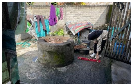
Gambar 7. Pengukuran Teknis Bangunan Sumur Gali pada Kemiringan Lantai Sumur
