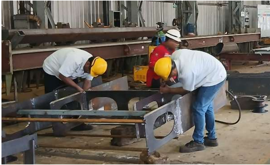
Proses Drilling (Pengeboran) di unit Produksi Welding 2
