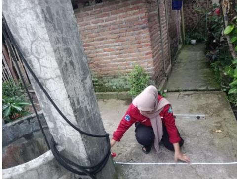
Gambar 9 pengukuran lantai sumur
