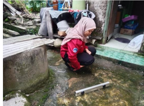
Gambar 10 pengukuran kemiringan sumur menggunakan waterpas
