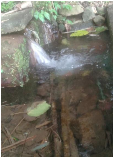
Gambar 7. Kondisi sumber air terbuka
